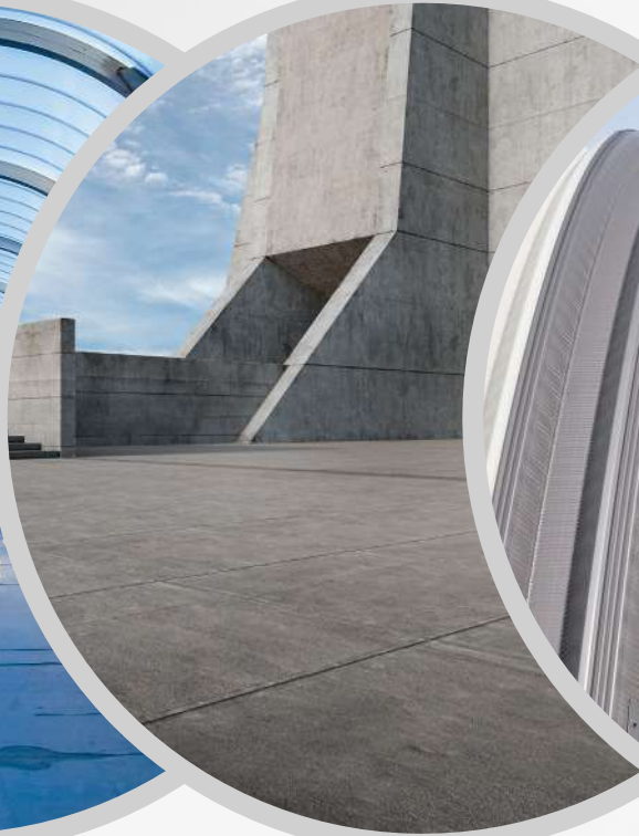
Pisos de Concreto
